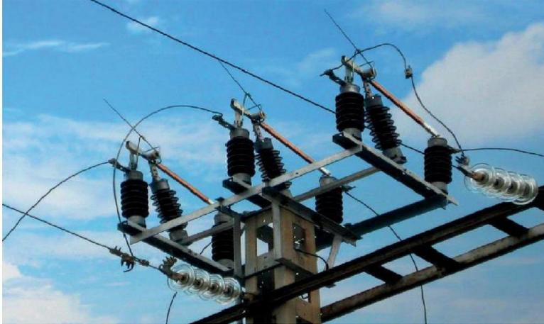
Interrupteur aérien à commande mécanique (AMER A, AMZAL B.
